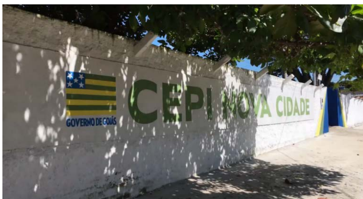
Fig. 5 - Fachada da escola
