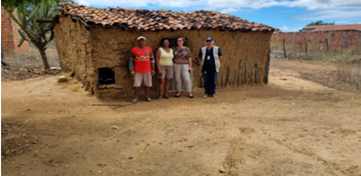
Figura 6 - Casa feita de taipa: antiga moradia de Valdete
