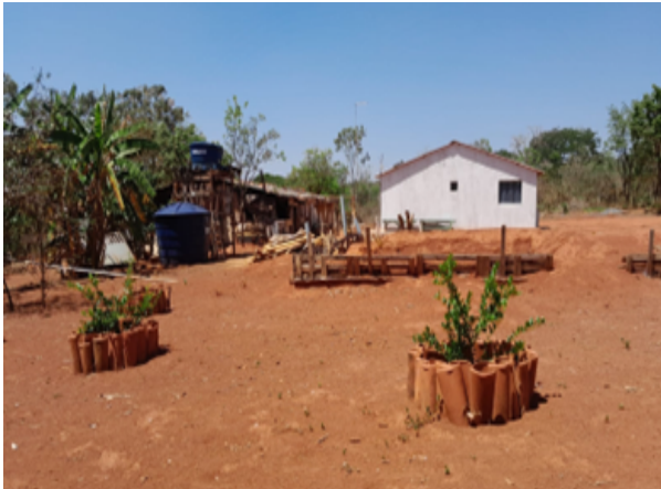
Figura 33 - A casa de alvenaria
